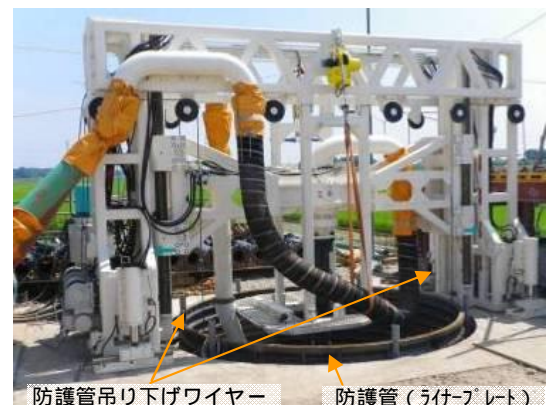
図-2 門型の掘削機
