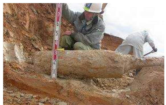
写真-2 掘り出した拡孔部（補強材 A）
