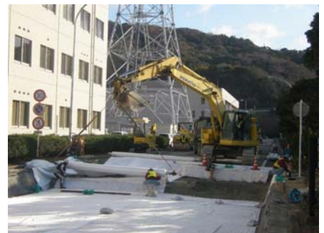
写真1 ジオテキスタイル敷設状況
