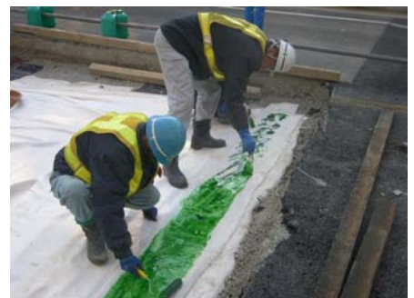
写真2 接着剤塗布状況
