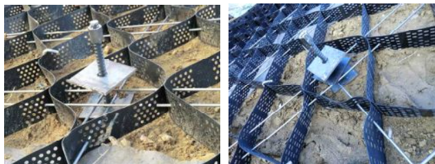
写真5 標準的な頭部処理工の例
