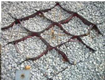
写真3 中詰め工 (アンカー部)
