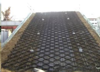
写真2 縦および横筋設置
