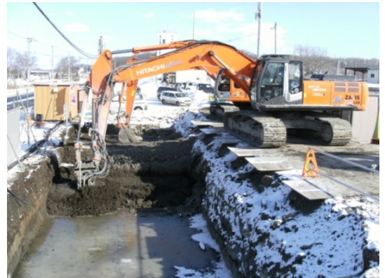
写真-2 寒冷地(厳冬期)での施工状況
