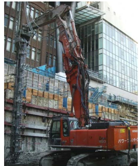
写真-3 建築基礎での施工状況
