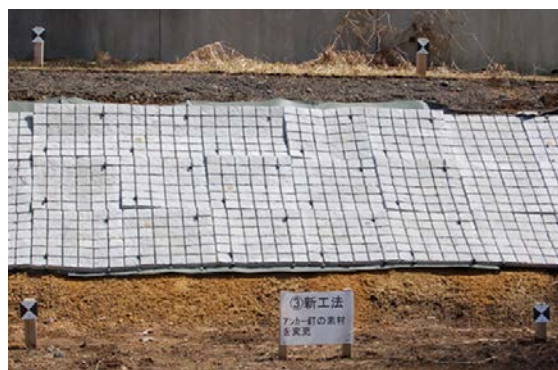
写真-1 現地計測現場
