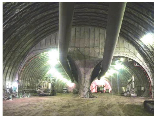
写真-1 超近接トンネル発進部
