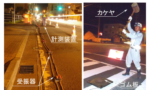
図-2 探査状況写真
