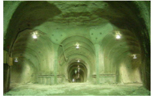
写真-1 水路部掘削完了時
