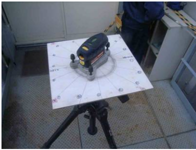
写真-1 位置出し用プレートとレーザー
