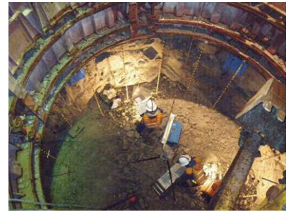
写真-3 壁面地質観察作業状況
