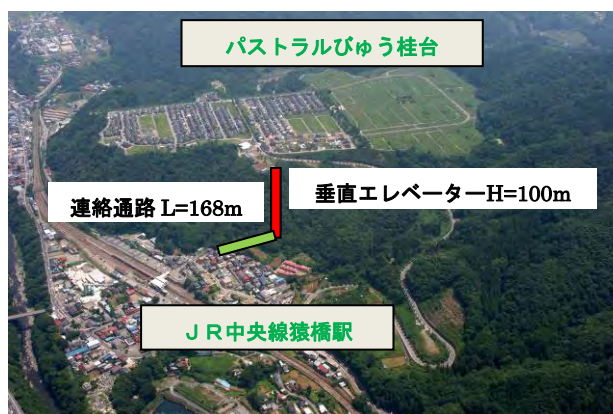
写真－１「パストラルびゅう桂台」とエレベーター施設
