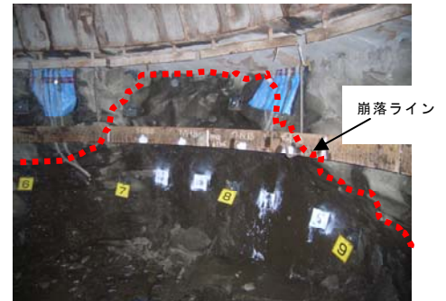
写真-1 崩落対策工（増しRB）
