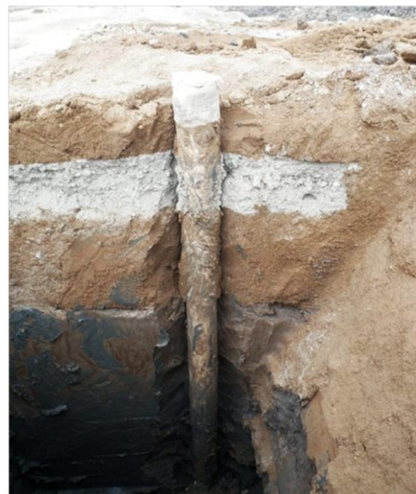
写真1 杭状地盤改良体
