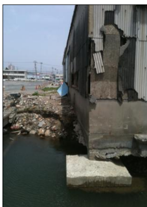
図-2 いわき市小名浜港倉庫基礎
