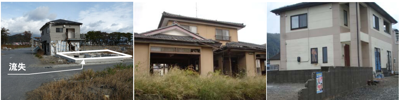
(a) (b) (c) 図2 建物の被災状況の分類(一例)
