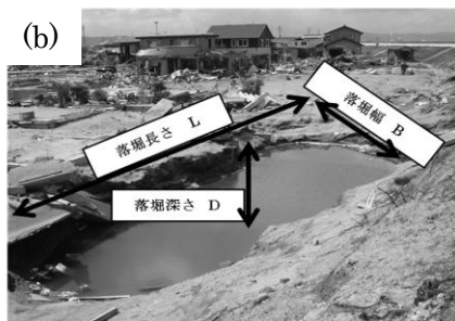
図-1 堤防侵食と落堀の定義図 (a) 堤防侵食, (b) 落堀
