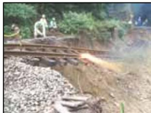
写真-4 軌きょう撤去作業
