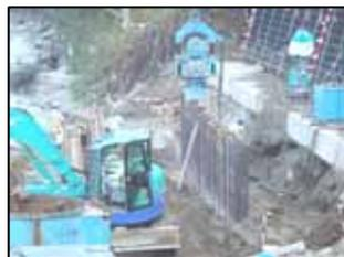
写真-6 鋼矢板打設
