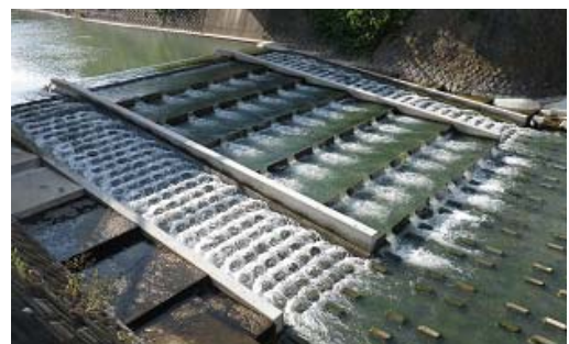
d) 改善後(斜路式の魚道と階段工が設置)
