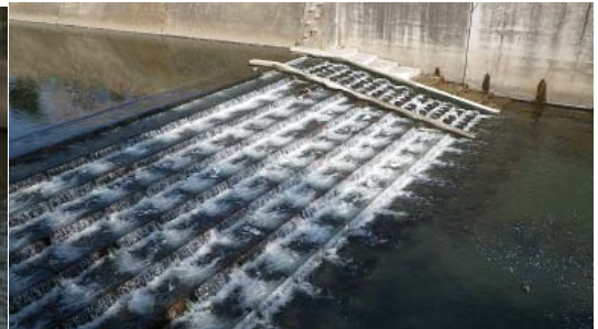
b) 改善後(斜路式の魚道と階段工が設置)
