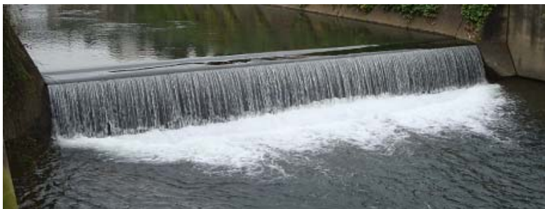
a) 改善前(落差部直下流で露出射流が形成される)
