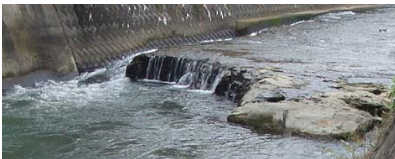
c) 改善前(河床低下によって生じた段差)
