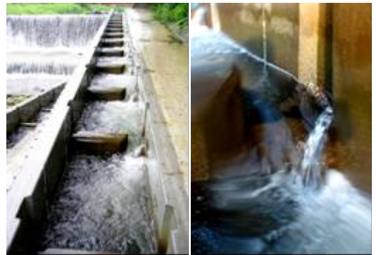
写真-1 施設全景(左)、側壁凹部の流況(右)
