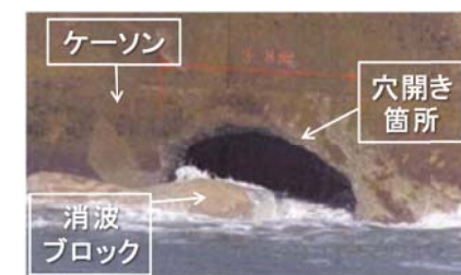
写真-1 実際の穴あき被害
