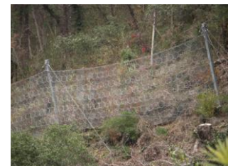
図-1 ワイヤリング落石防護柵
