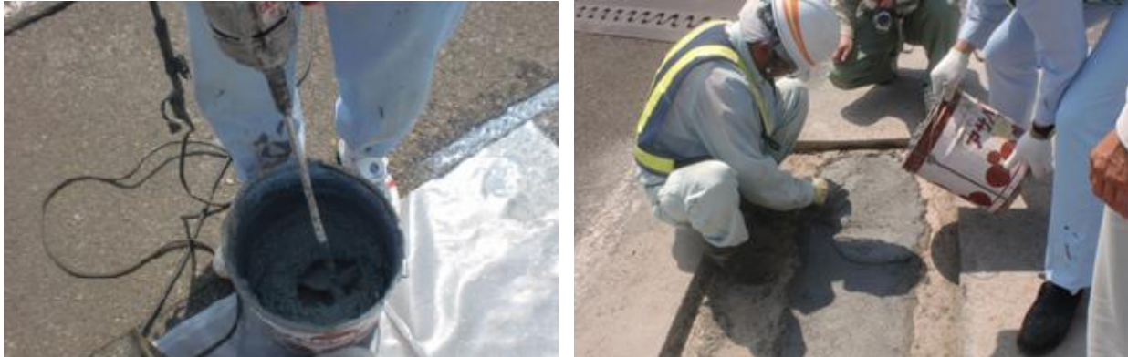
図-3 施工状況(練混ぜ及び流し込み状況)
