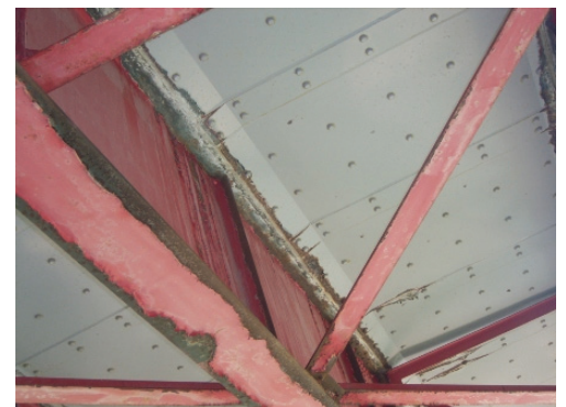
写真-1 床版下面の状況
