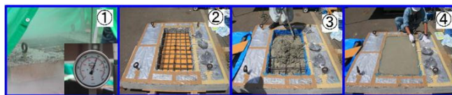
図-3 WJおよびコンクリート打設
