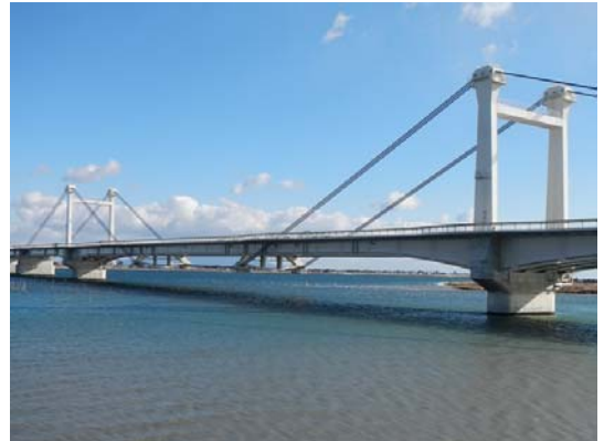
写真-1 阿波しらさぎ大橋 (ケーブルリグレット部)
