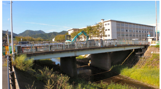
写真1 対象橋梁の全景
