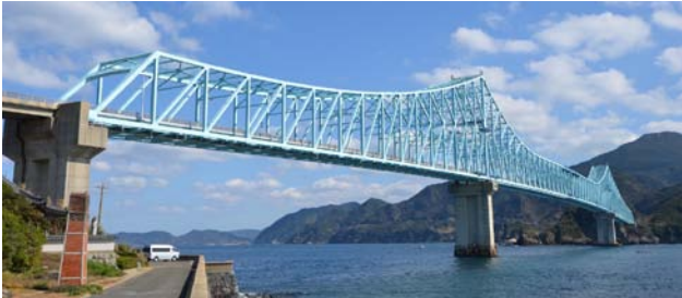
図1 遠隔計測対象橋梁（生月大橋，長崎県平戸市）
