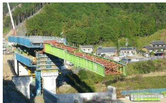
写真1 鋼橋の架設状況
