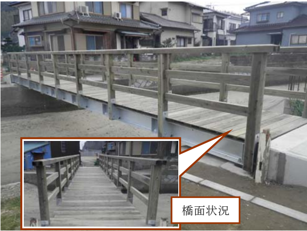
写真-1 対象人道橋の全景
