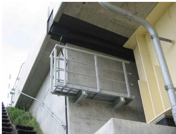
写真 1 FRP 検査路
