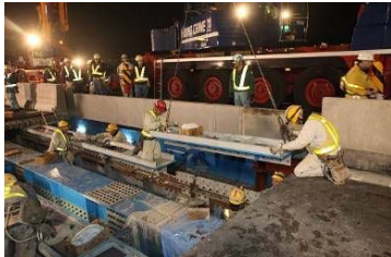
③T字部材架設
