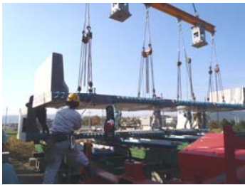
写真-2 現場先行搬入したPC床版 による取付け確認・訓練
