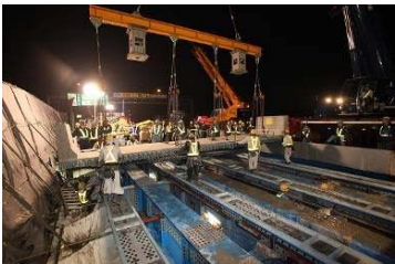
④P C床版架設
