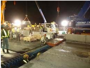
①仮設鋼床版撤去
