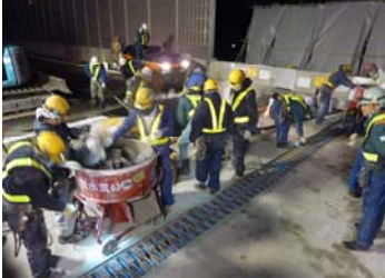
⑤間詰めモルタル打設
