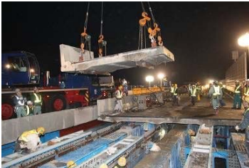
②既設床版撤去
