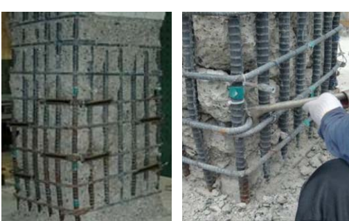
写真-1 帯鉄筋の再閉合状況
