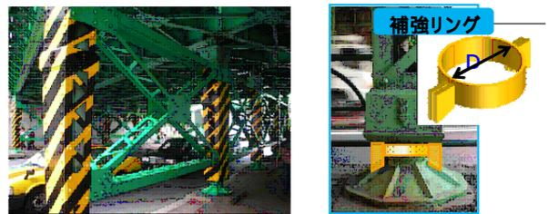
図2 耐震補強工法の例
