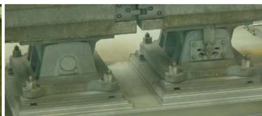
図 2 PC 桁への設置事例 (左:固定, 右:可動)
