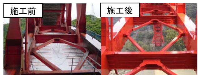
写真-3 下横構 SBBR 施工前後
