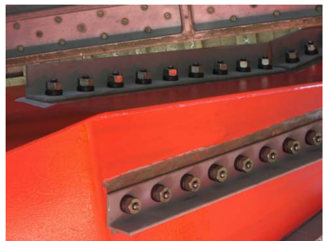
写真-4 ワンサイドボルト施工
