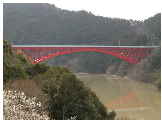
写真-5 橋梁全景(施工後)
