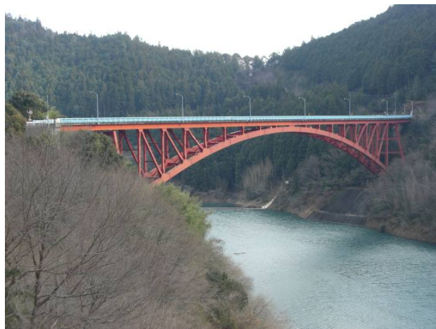
写真-1 橋梁全景（施行前）
