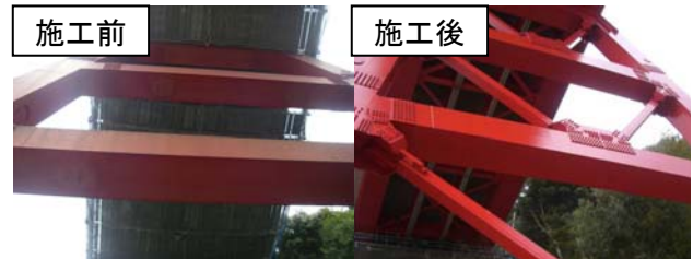
写真-2 端柱 SBBR 施工前後
