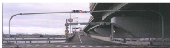
写真-1 比較的軽量な大型門型柱の例
