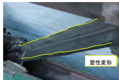
図 6 芯材部変形状況
