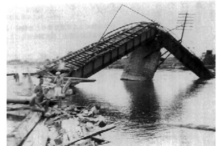
写真-1 旧式橋脚の地震損傷例(大きく傾斜)
