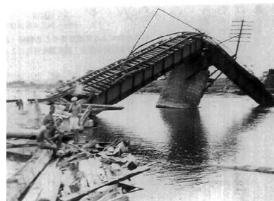
写真-1 旧式橋脚の地震損傷例(大きく傾斜) 1)
