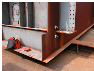
写真-1 箱桁橋の計測状況
