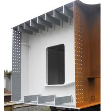
図-1 耐候性鋼材の塗装例
