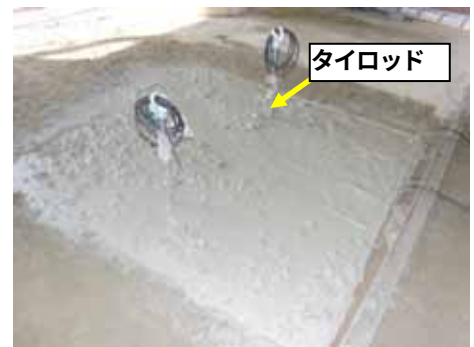
図4 構築後の安定処理土層
