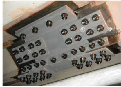
写真-2 Y型リブ取替状況
