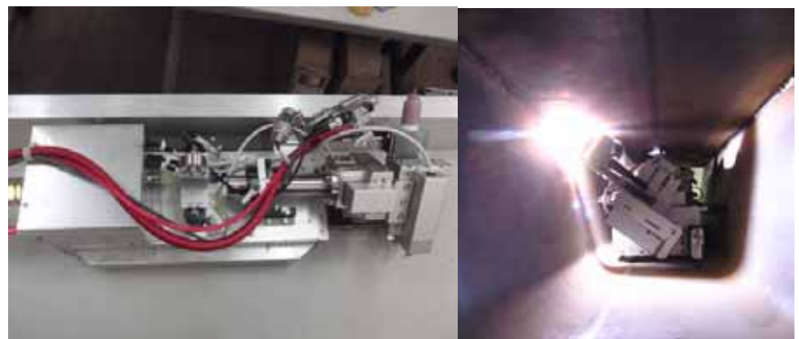
写真4 鋼床版トラフリブ内での補修状況
