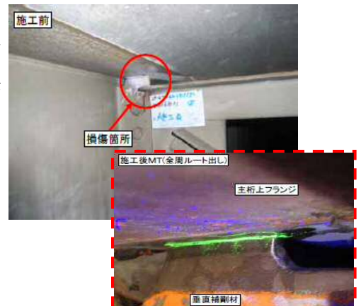
図-1 全周溶接ビード除去状況
