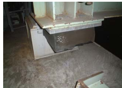
写真-3 P56 支承
