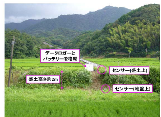
図1 地震計の設置状況(低盛土)
