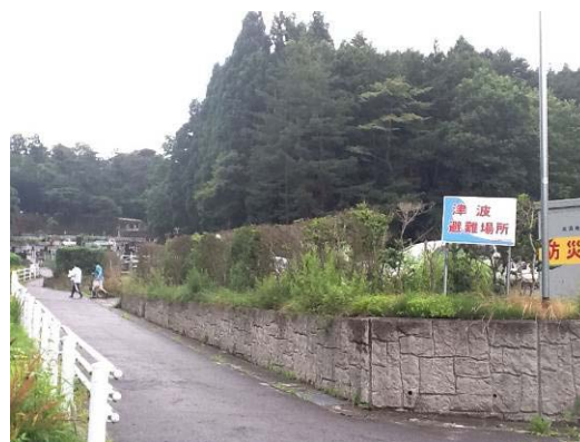
写真1 b区の津波避難場所看板と備蓄倉庫
