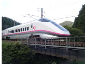
図-2 秋田新幹線 上路プレートガーダー
