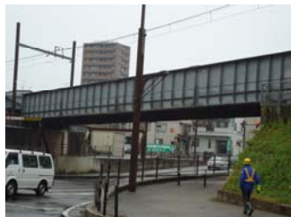
図-1 越後線 下路プレートガーダー
