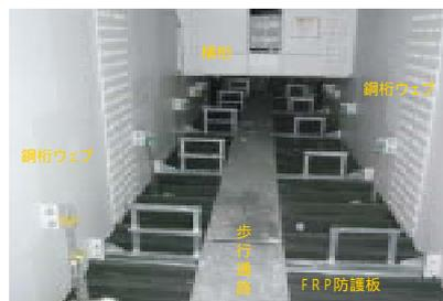
写真-1 FRP 防護板設置状況
